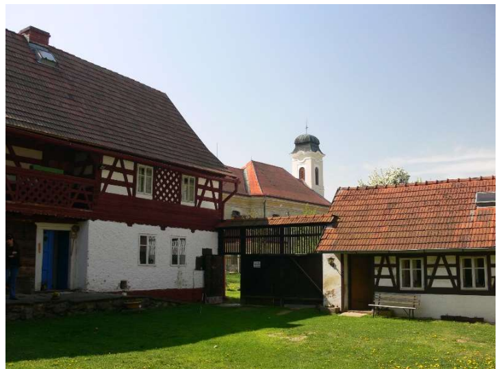
Vor der Renovierung
